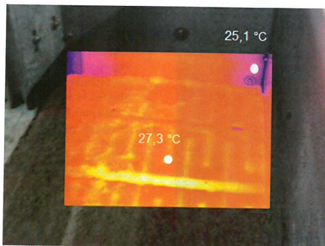
Der ses en jævn varmefordeling i pattegrisehulen ved brug af gulvvarme i plastplade.
